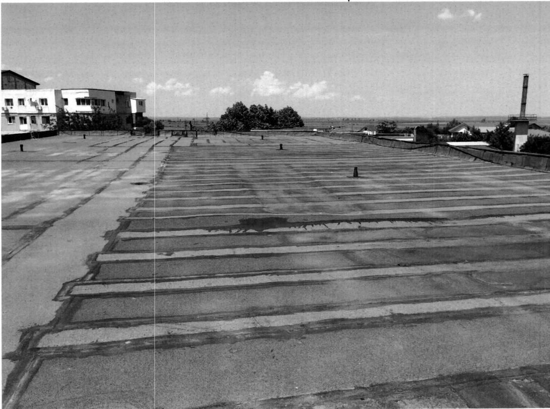
Foto nr. 6 Acoperiș Terasă
