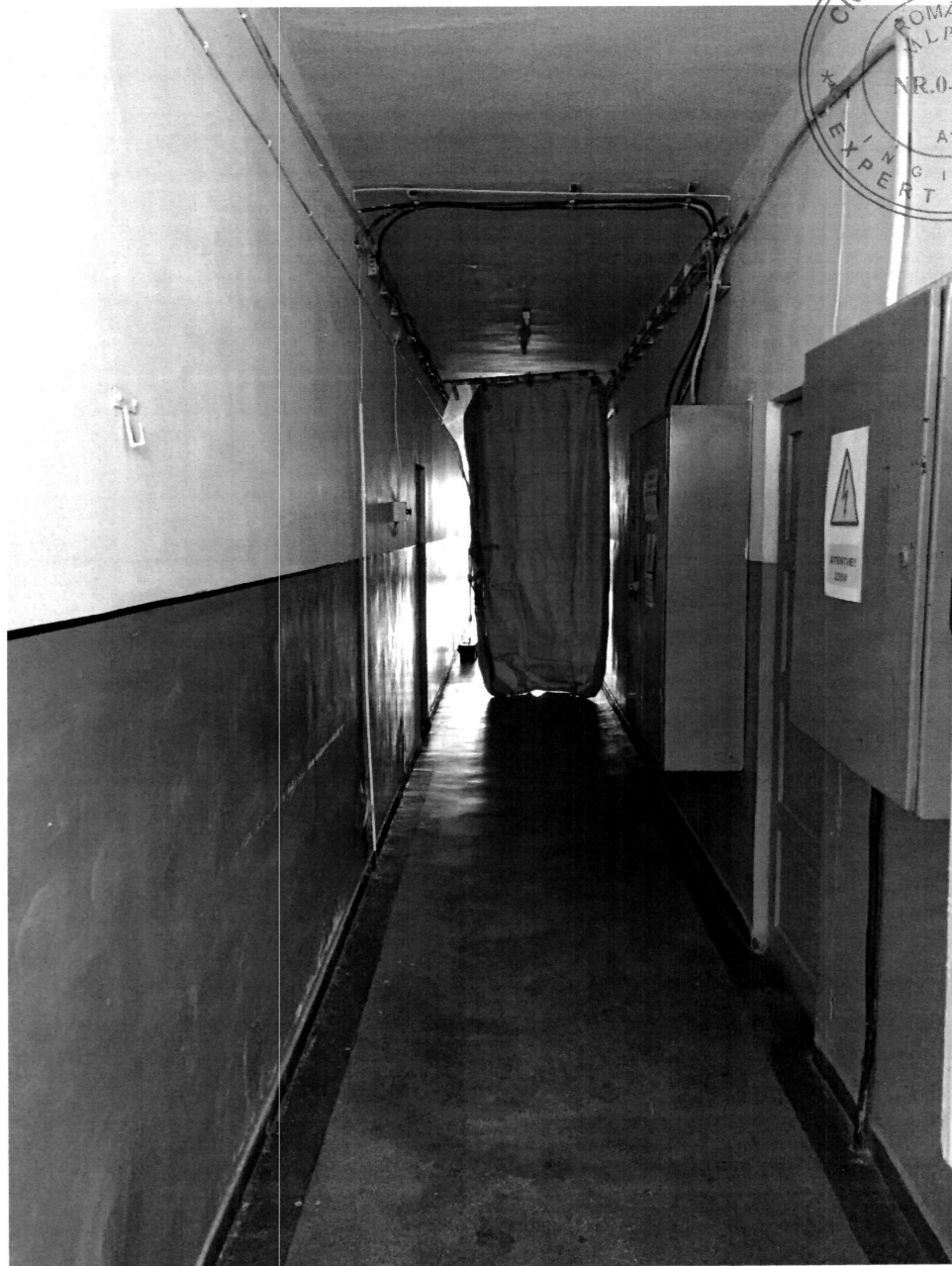
Foto nr. 13 Interior Clădire
