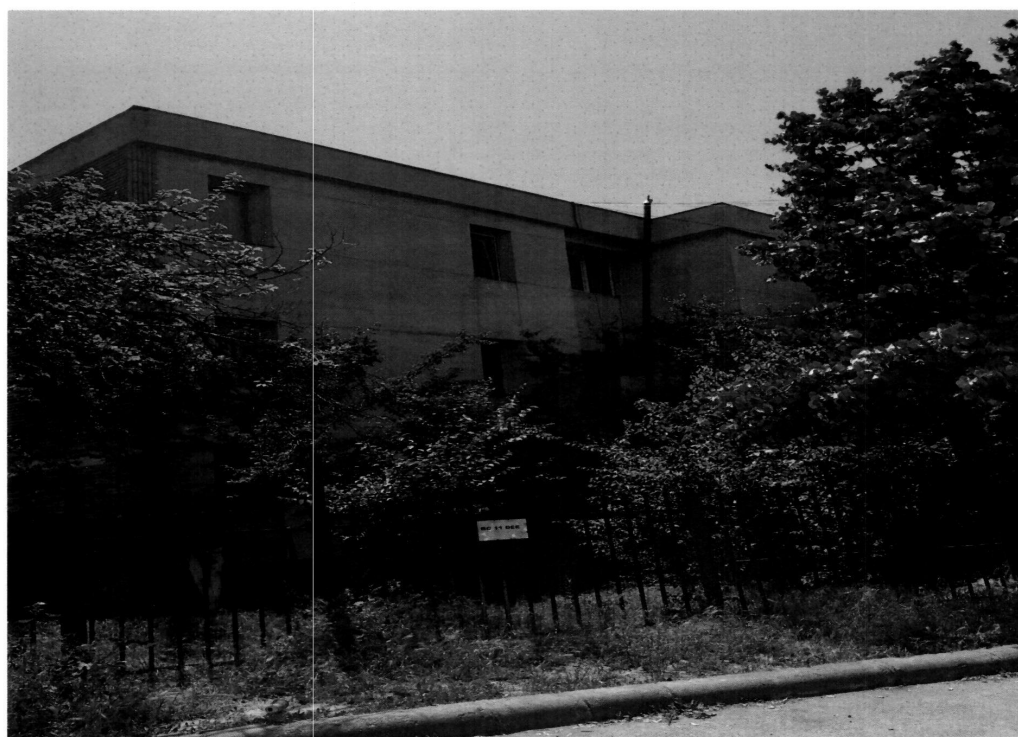
Foto nr. 2 Fațadă Laterală
