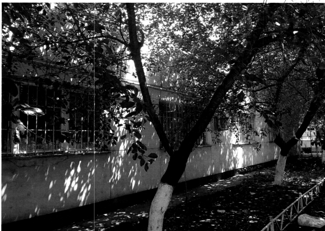
Foto nr. 3 Fațadă Principală
