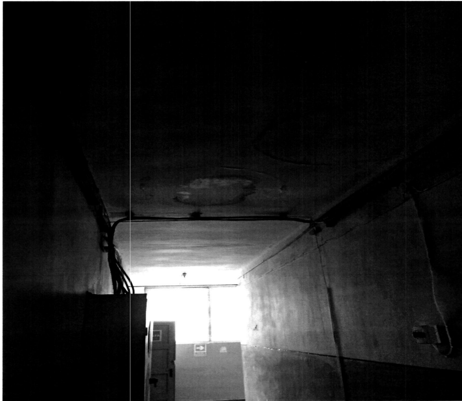
Foto nr. 12 Infiltrații Terasă
