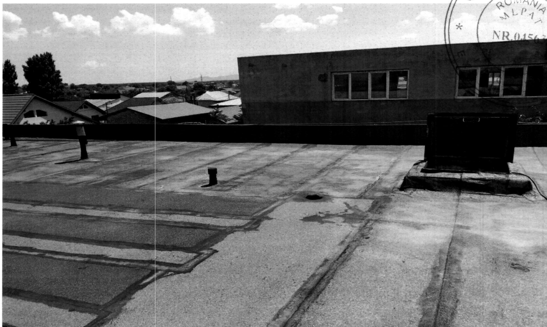
Foto nr. 7 Acoperiș Terasă
