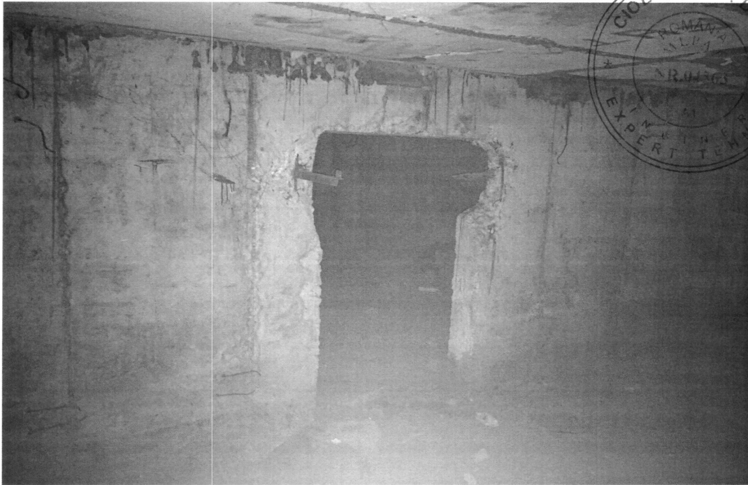
Foto nr. 11 Interior Subsol
