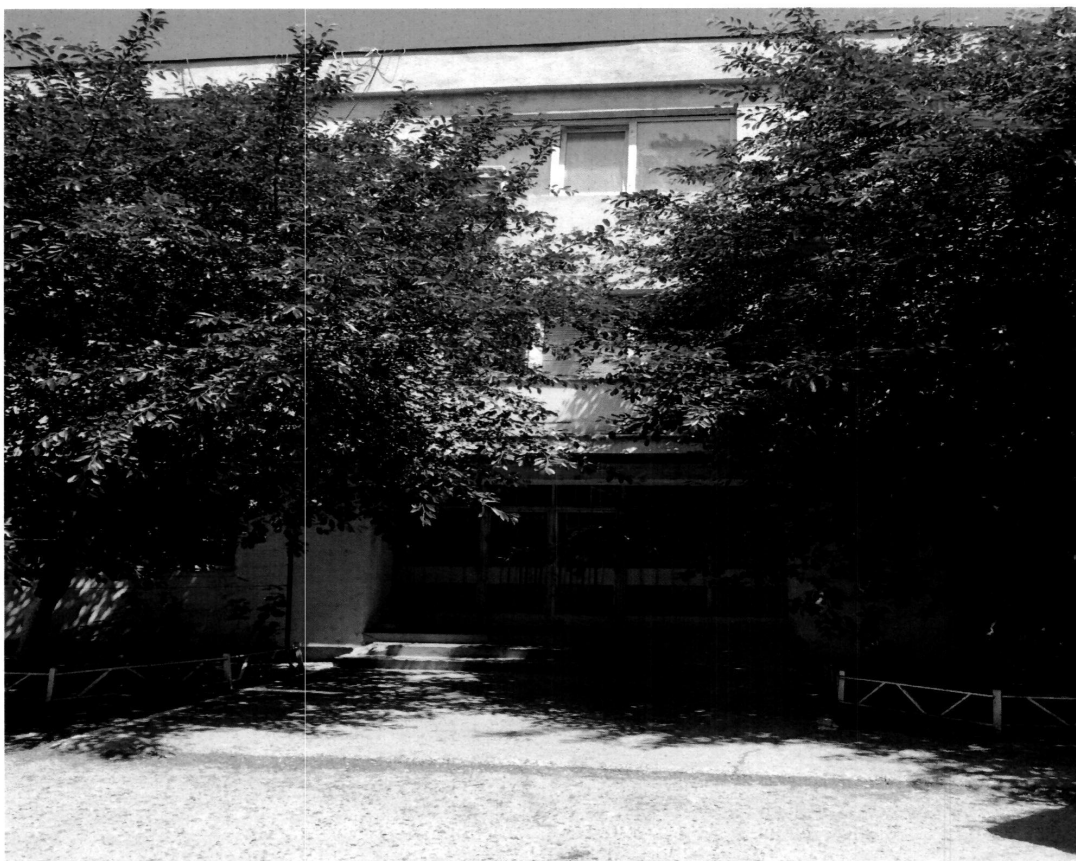
Foto nr. 8 Fațadă Principală – Acces Clădire
